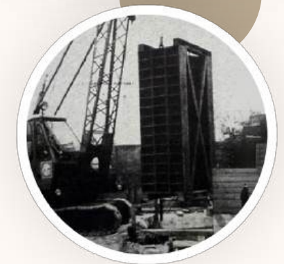
Einbau Widerlager für Großrohrpressung
