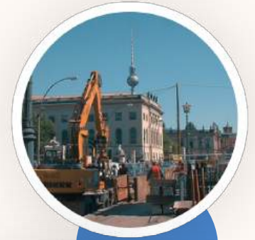
Rohrverlegearbeiten auf der Straße Unter den Linden.
