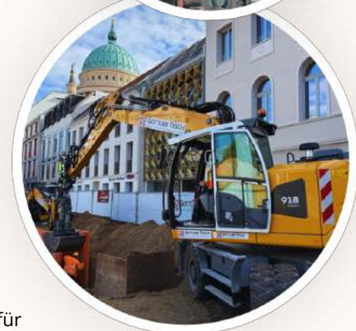
Bau eines Abwasserkanals in Potsdams Mitte
