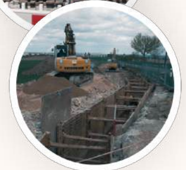
Verlegung von Trinkwasserleitungen bei Peine
